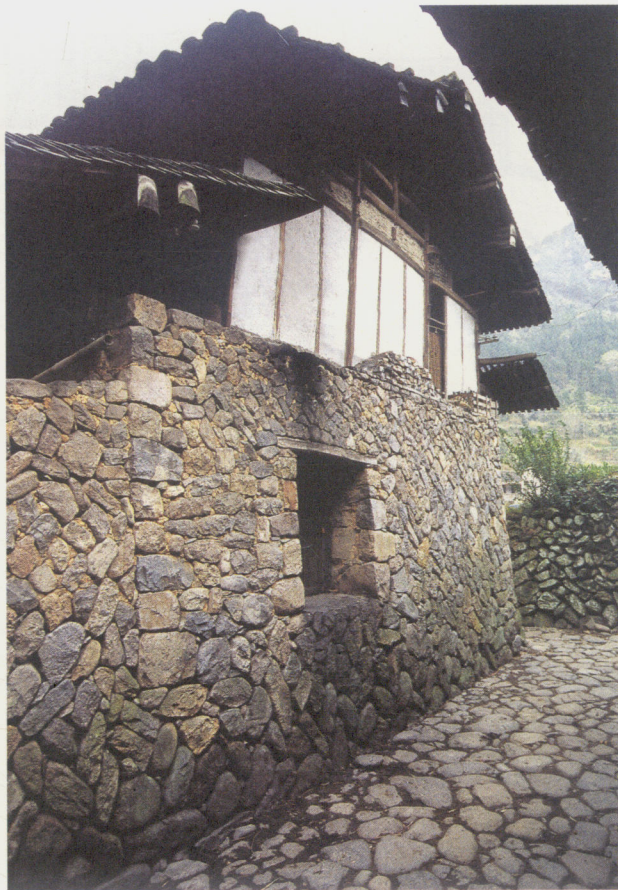
永嘉县林坑村蛮石砌筑的住宅
