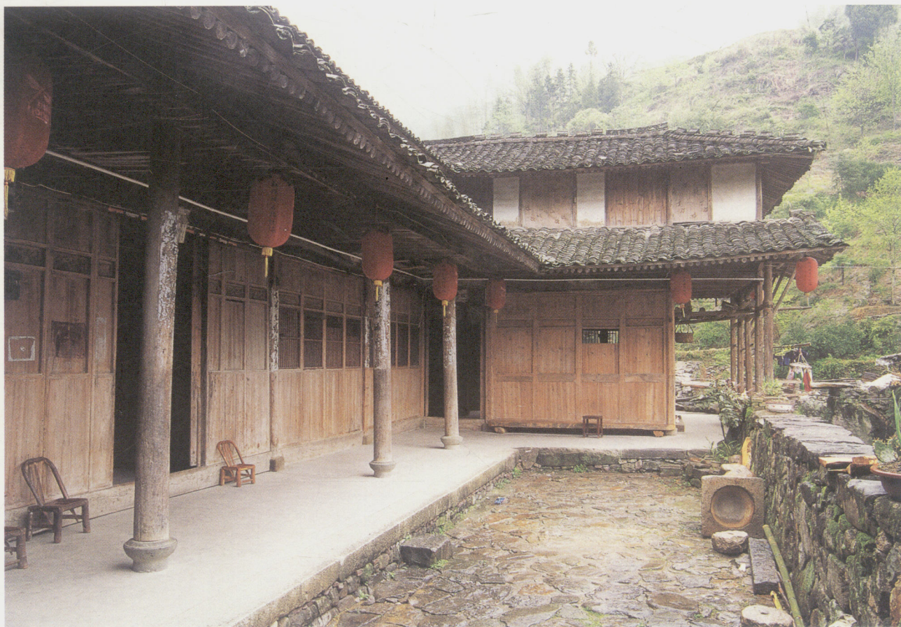
永嘉县林坑村住宅院内
