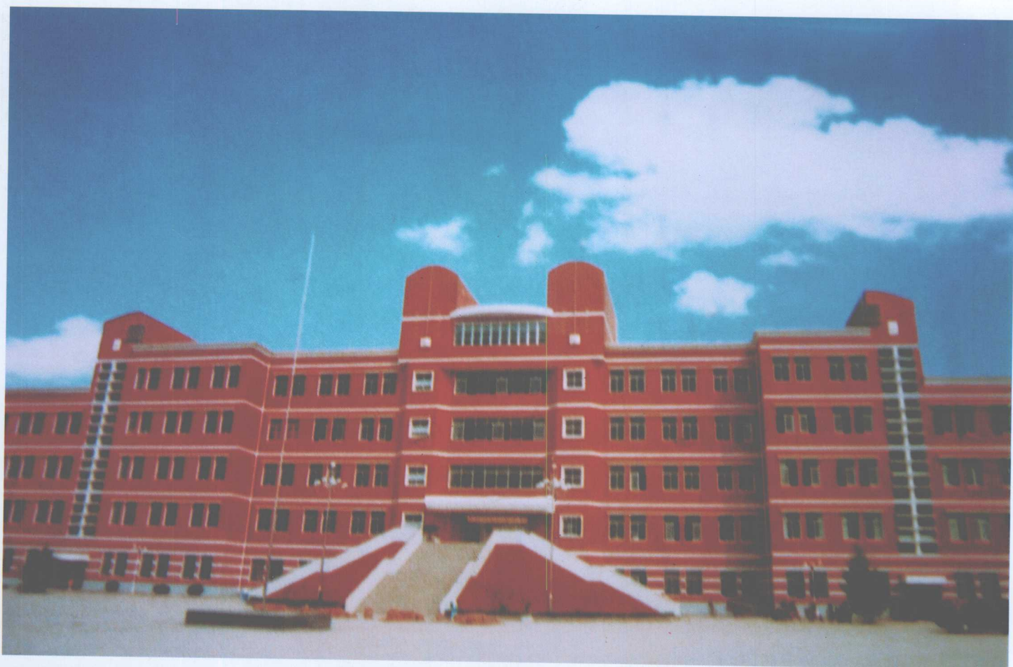
焦作四中综合教学楼
