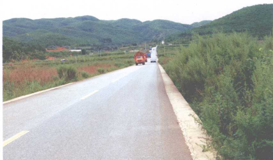
晋宁加大基础设施建设，修建了古（城）二（街）、宝（峰）夕（阳）、上（蒜）六（街）、晋（城）新（街）等县乡公路。图为宝夕公路宝峰段。
