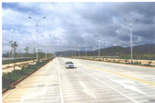
晋宁加快城市建设步伐，新修了永乐大街、东风路、东绕城路、东南绕城路。图为永乐大街南段。
