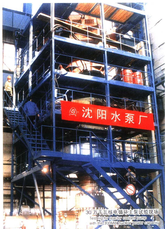
沈阳水泵厂30万千瓦核电循环主泵试验现场
