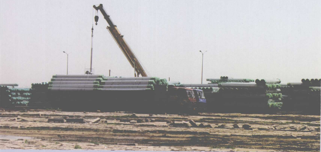
秦山公司后堆场带钢垛存作业
