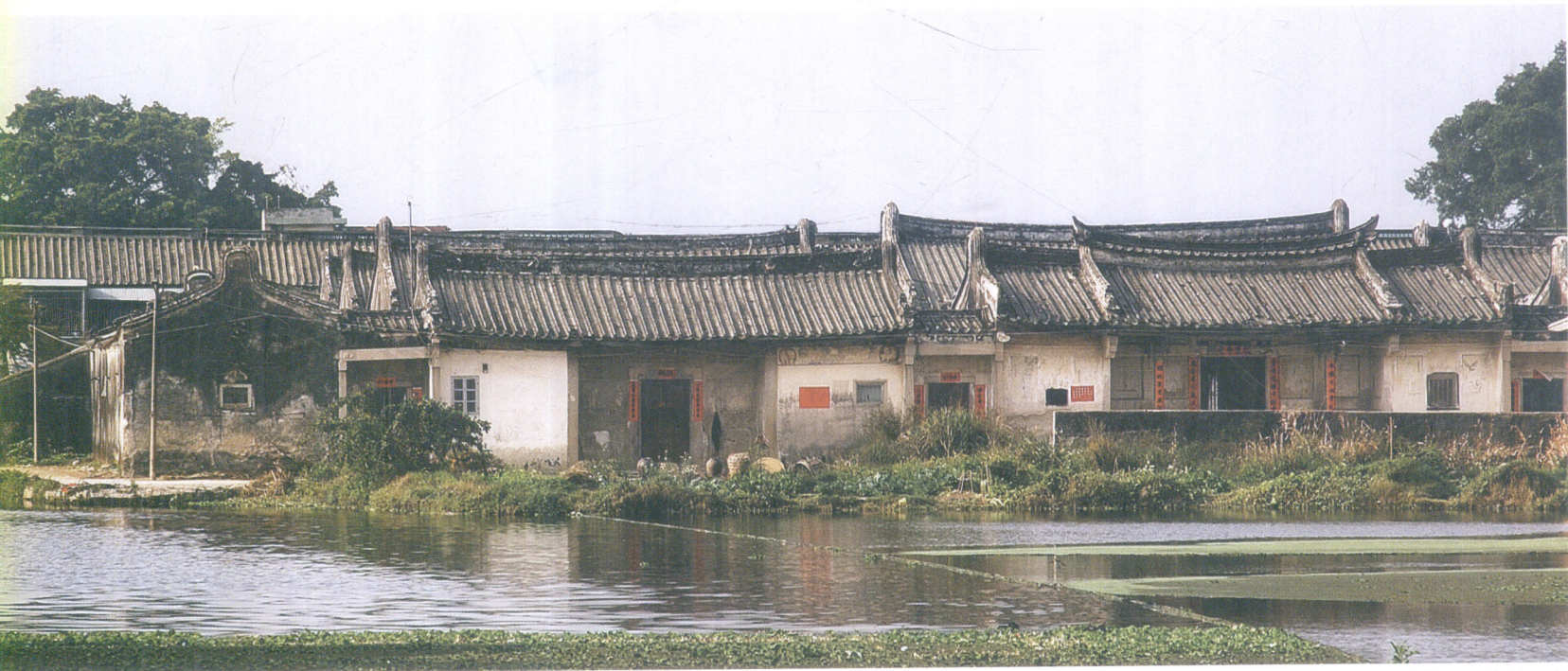
浮洋镇厦里美村一角
