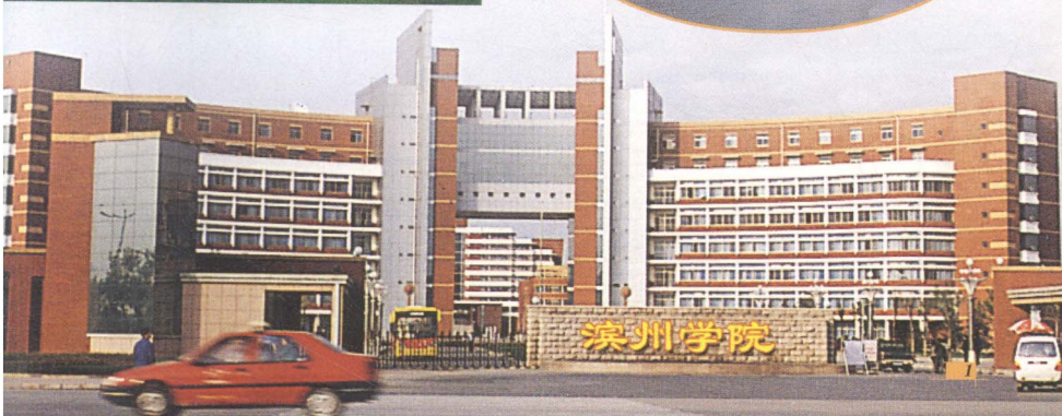
理科楼、图书馆、文科楼
