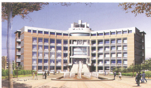
北镇中学综合楼
