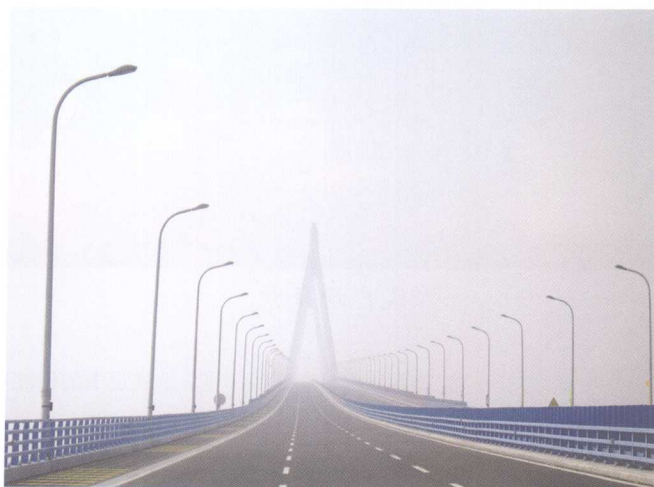
杭州湾跨海大桥
