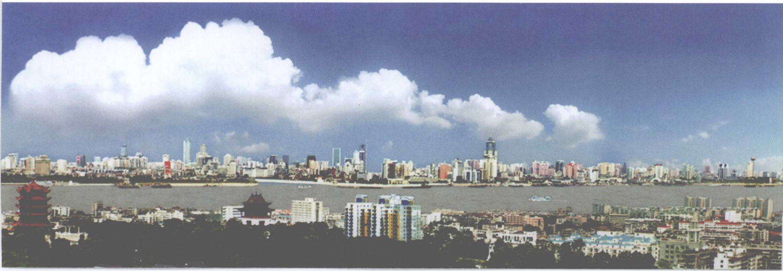
武昌汉口长江两岸建筑景观
