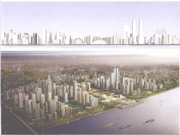
正在建设中的钱江新城全貌
