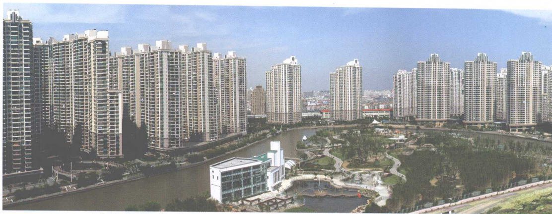
2003年9月，“两湾一宅”（潘家湾、潭子湾、王家宅）一、二、三期改造工程完成。上图为新建的“中远两湾城”部分楼群
