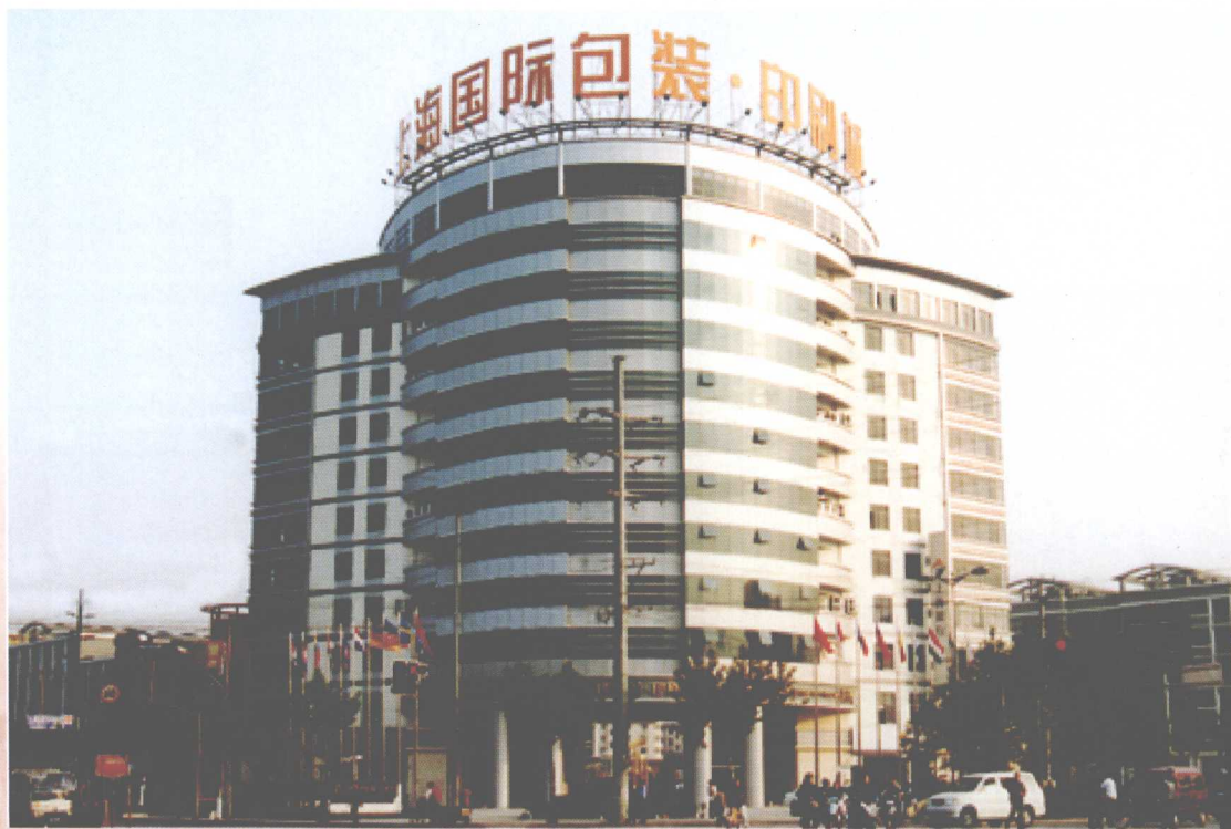
2003年建成的上海国际包装·印刷城主楼
