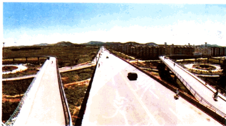
市区高速公路
