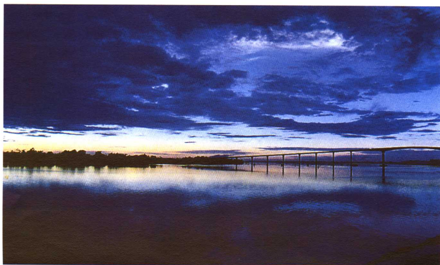
苏里南河大桥
