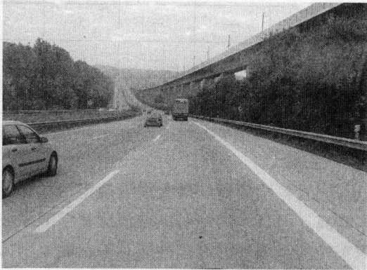
图 1-2 德国高速公路 6% 的长大下坡路段
