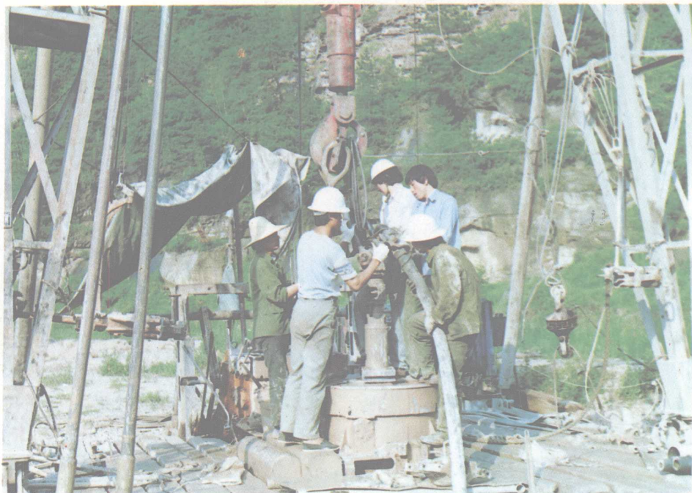
旬邑钻探野外施工现场
