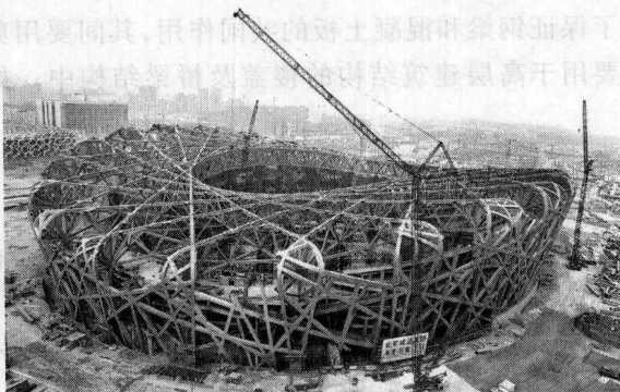
图 1.2.3 建设中的国家体育场
