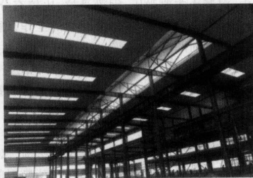
图 1.2.5 轻型钢结构厂房
