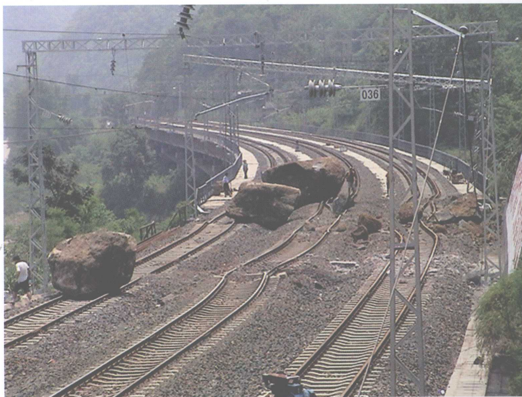
图9 盐津地震破坏铁轨
