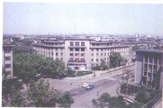
地处株洲市贺家土的省煤田勘探公司的办公大楼
