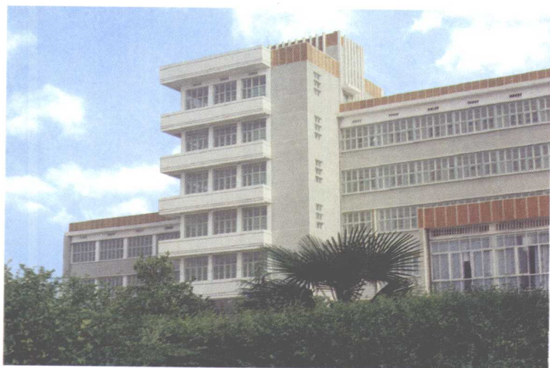
由联合国援建的长沙中小煤矿安全技术培训中心主教学楼
