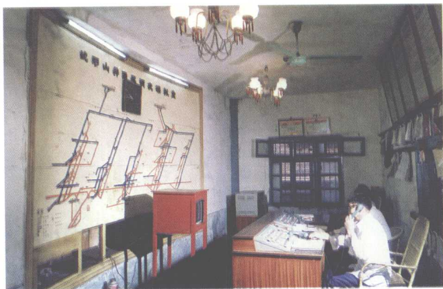
洪山殿煤矿蛇形山井 通风调度模拟盘
