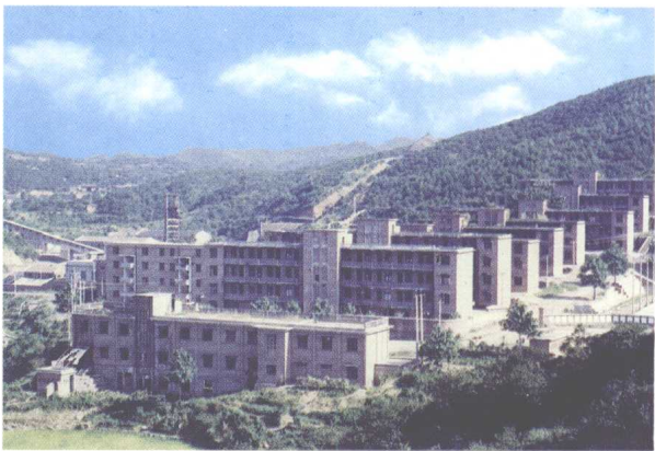
新建设的矿工职工宿舍
