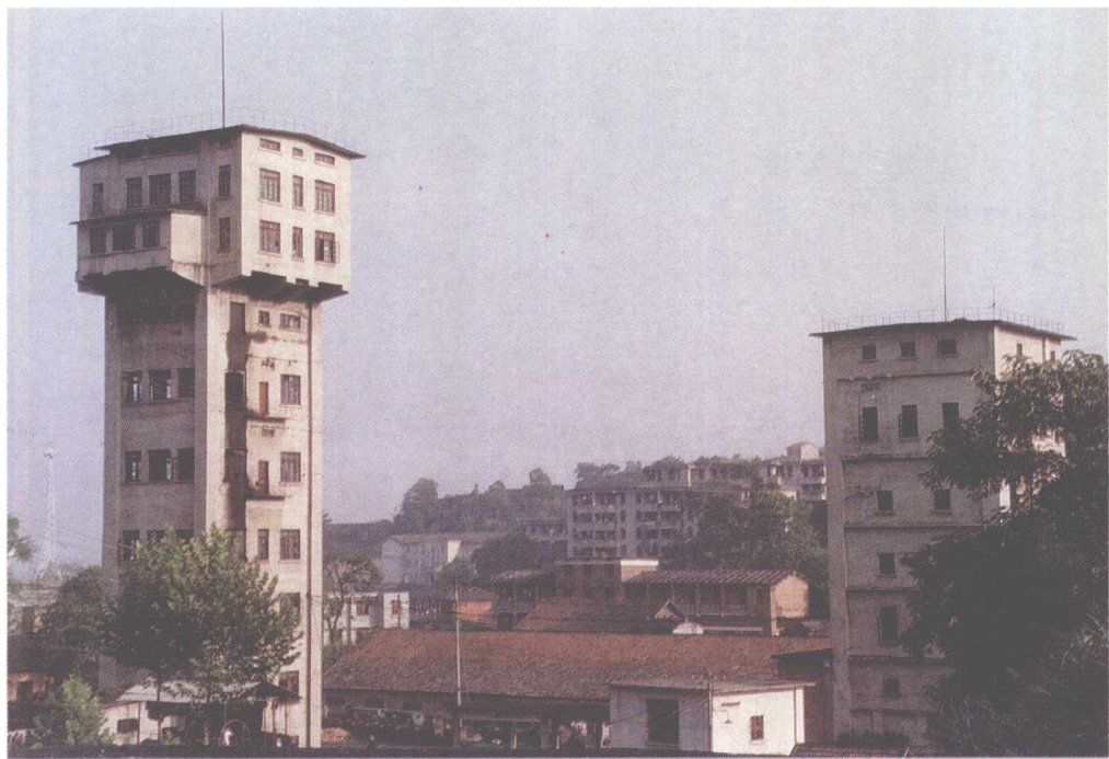
生产能力 45 万吨 / 年的资兴矿务局周源山矿主、副井井塔
