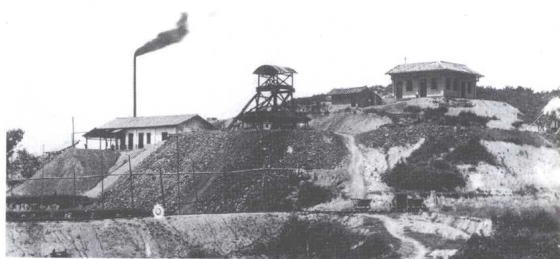
祁零煤矿局第二号大井及井口设备
