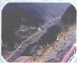
在建工程江坪河电站
