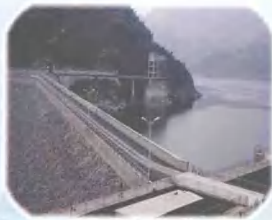
芭蕉河一级水库
