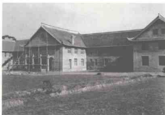
建设中的大学医院门诊部（今华西医院行政办公楼）
