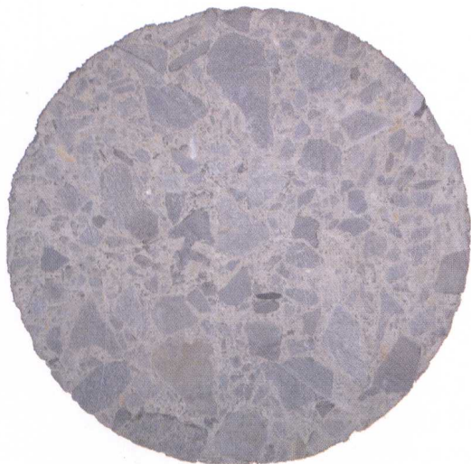
悬浮结构水泥稳定碎石基层芯样剖面
