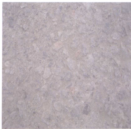
骨架密实结构水泥稳定碎石基层表面
