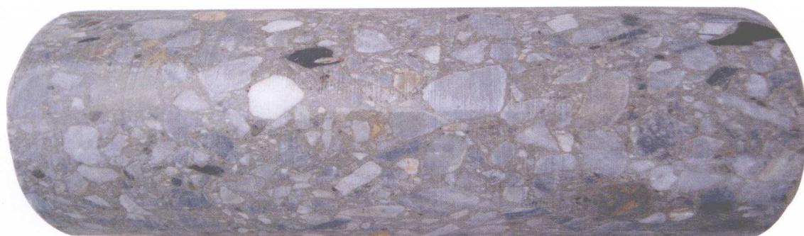
全厚式施工取芯照片
