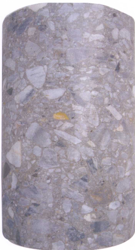
分层施工取芯照片
