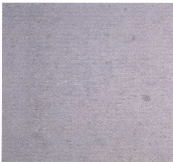
悬浮结构水泥稳定碎石基层表面
