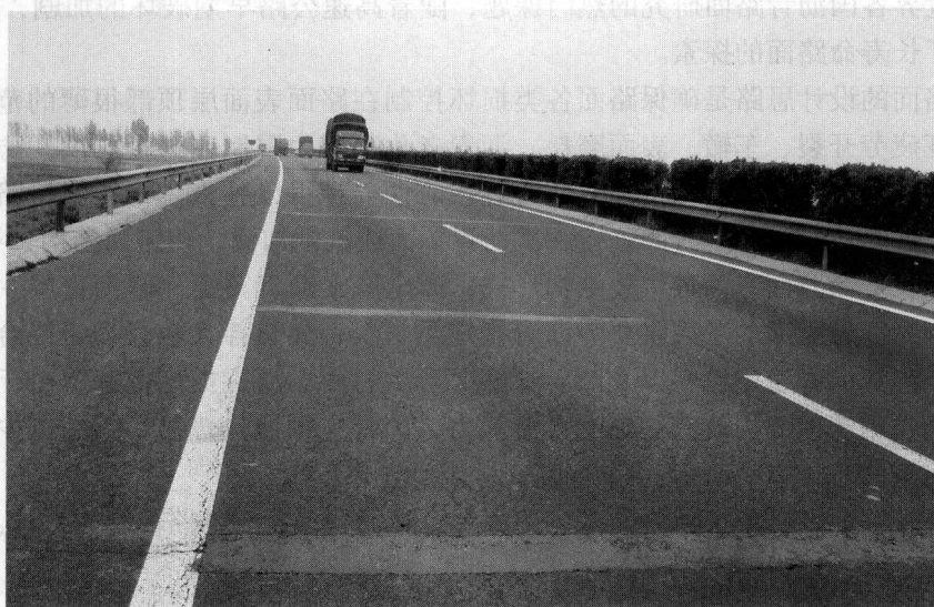
图1-1 半刚性基层的裂缝反射到面层
