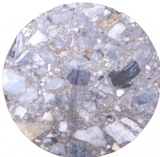
骨架密实结构水泥稳定碎石基层芯样剖面
