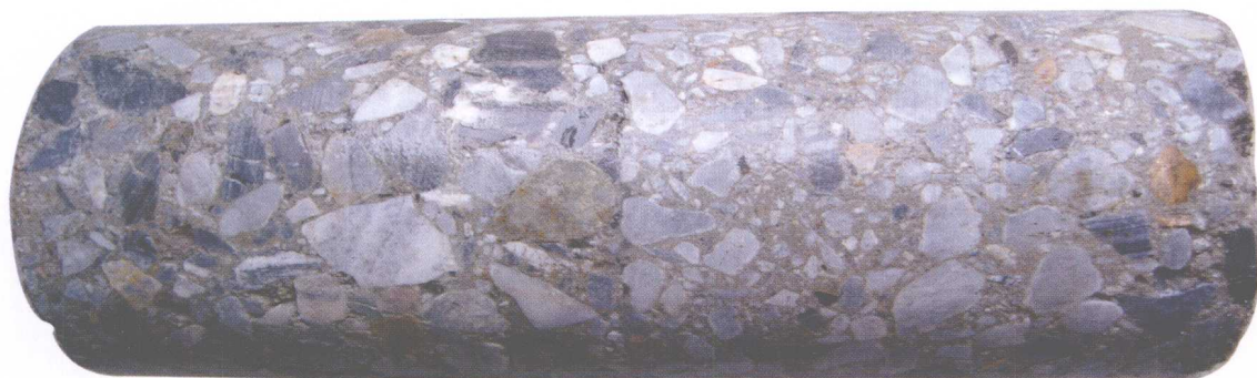
分层施工取芯照片
