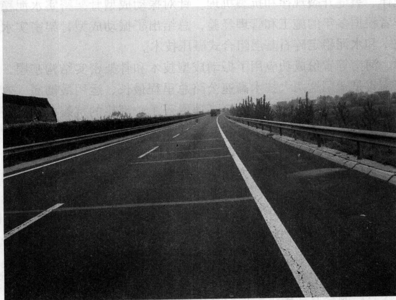
图1 半刚性基层的裂缝反射到面层
