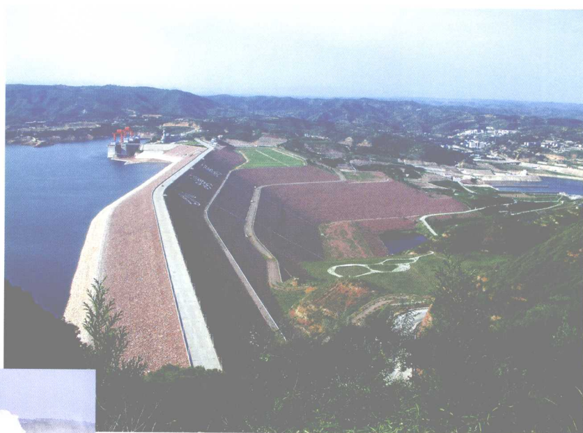
小浪底水库大坝 (王彤琪 摄)
