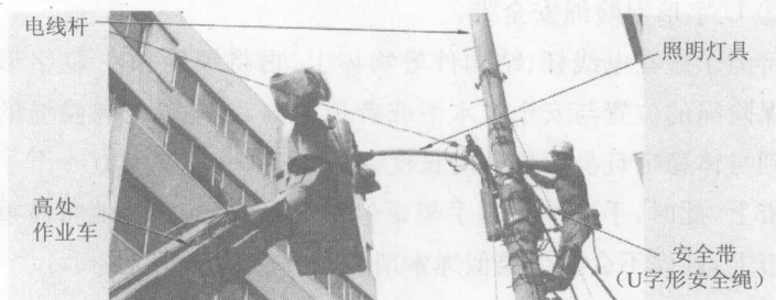
图 1.6 往电线杆上安装照明灯具的例子
