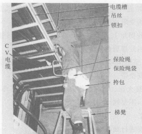
图 1.7 站在梯凳上进行电缆槽上的电缆绑线作业情况
