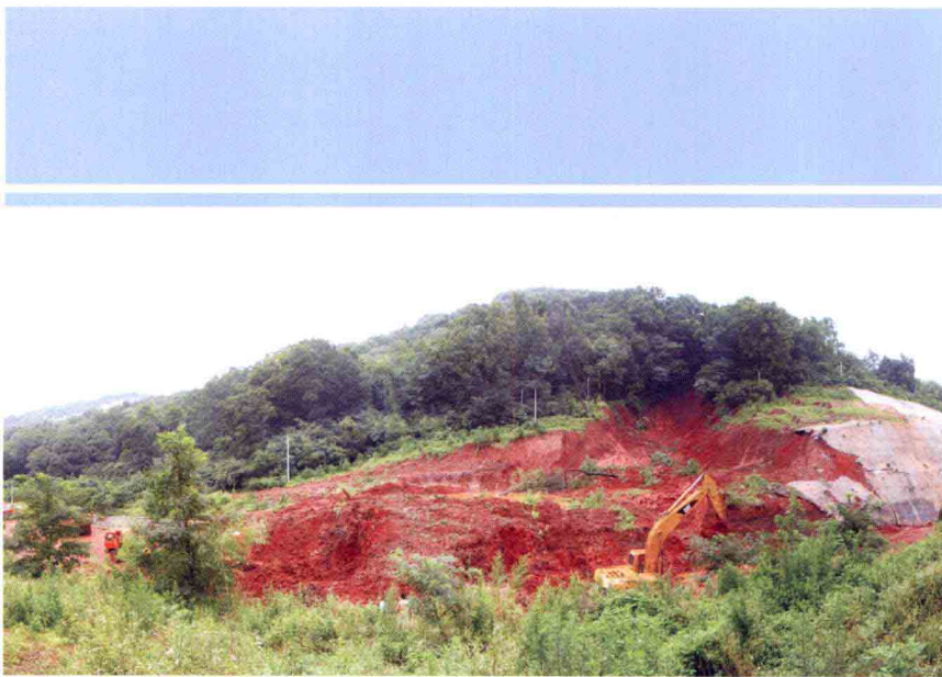
■ 黄山岭滑坡全貌
