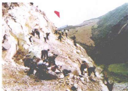
谭坝劈山修路工地一角
