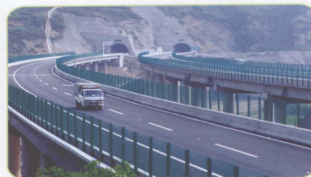
上海至瑞丽高速公路玉屏境内八仙岩隧道
