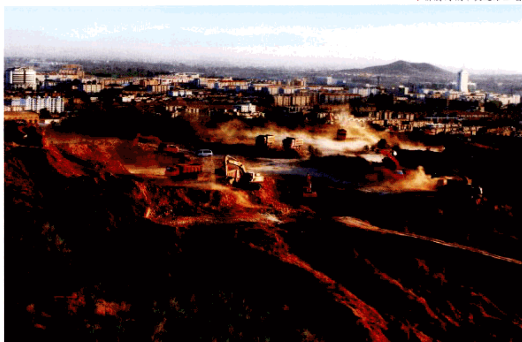
▼沸腾的城市快速路工地
