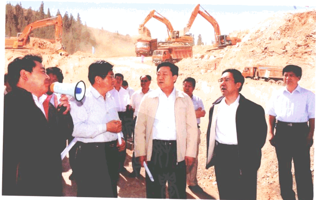
▼市委书记宋太平（中）、市长郑雪碧（前右一）、市委常委、副市长李建举（后右一）与市交通局领导一起在城市快速路施工一线现场办公
