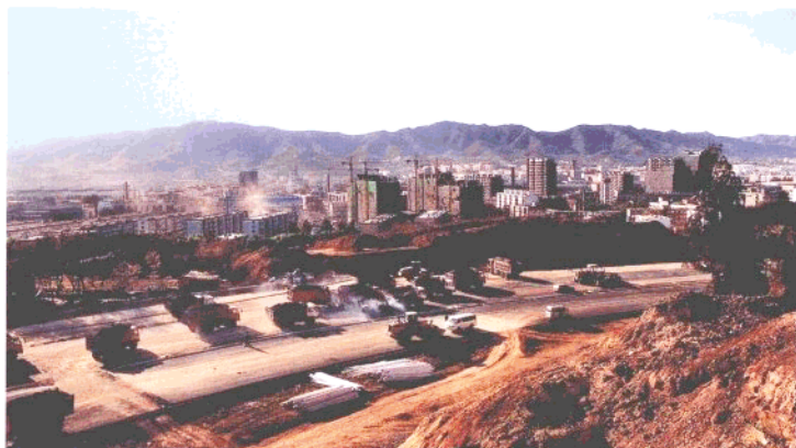
快速路东环线施工现场
