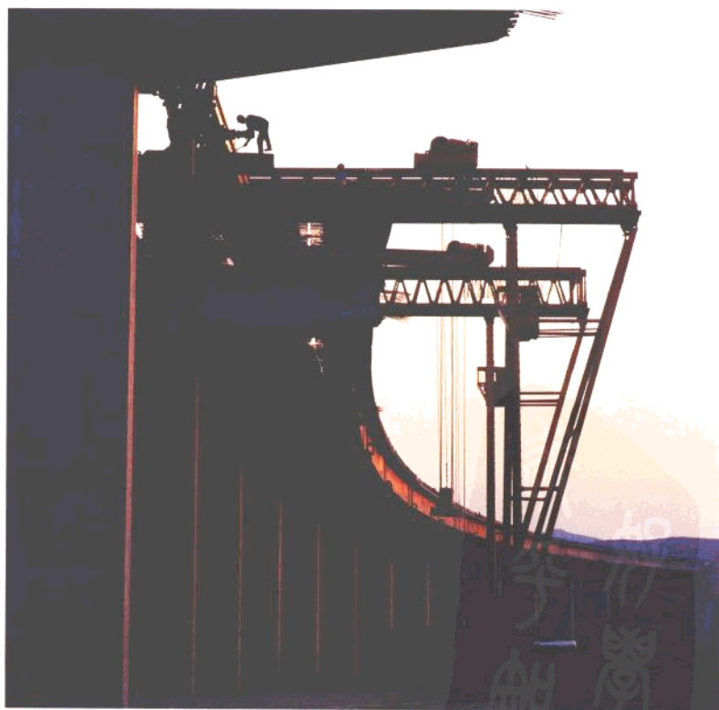
在建的京化高速公路一期工程黑山口大桥
