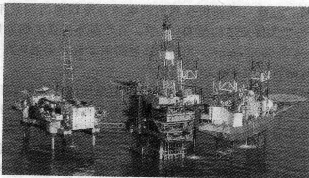
图 1-5 我国渤海湾海上采油固定钢平台
