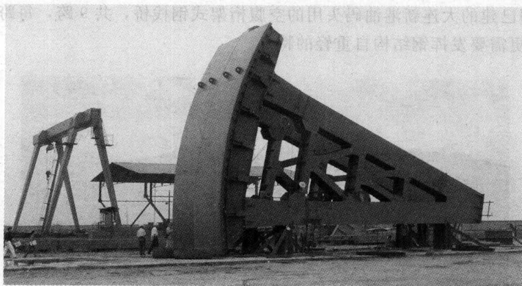
图 1-1 葛洲坝二江泄水闸弧形钢闸门
