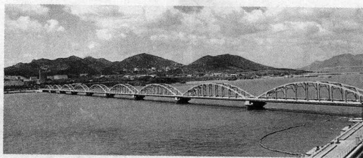
图 1-4 大连新港油码头钢栈桥
