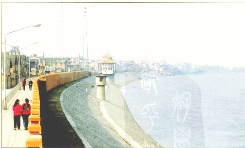
桃源县护城垸防洪墙
