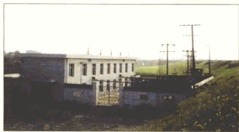
改建后的黄花井电排泵站
