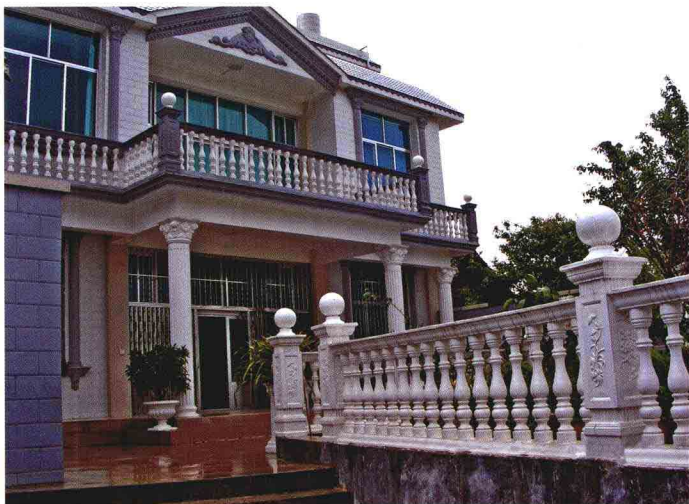
新民宅。勐廷新农村共有这样的砖混或框架结构平顶房45户，占民宅总数的25.8%。图为村民马永杰家中西合璧的小洋房。
