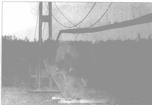
图1 Tacoma Narrows大桥600英尺的一段坍塌落入普吉特湾 (Puget Sound)，就像这座桥自己扭曲转动到坍塌一样。建筑工程师们早期就得到这方面的警告：如果他们不能苦练为一个优秀的工程师的话，就会发生这样的事故
