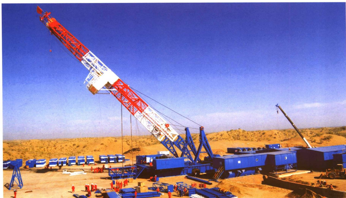
2006 年，中国石油天然气集团公司工程技术服务水平有新的提高，生产服务保障能力进一步增强。图为中国首台 9000 米钻机在新疆安全竖起
