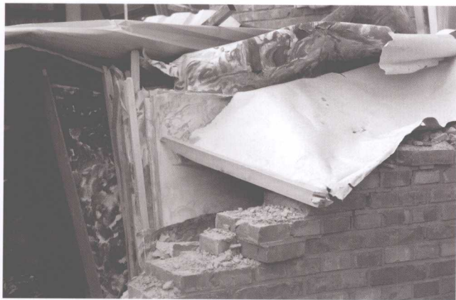
拆除后的索家村
