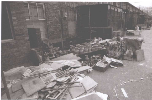
拆除后的索家村
