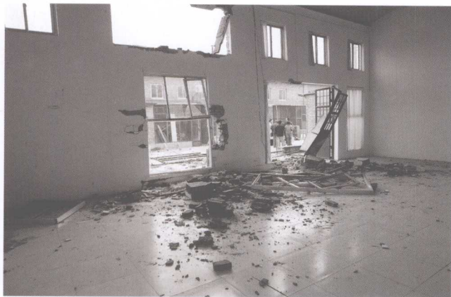
拆除后的索家村
