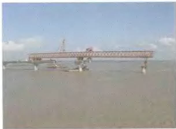
继续下一跨施工
