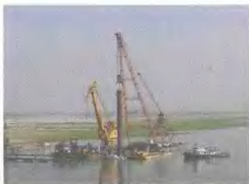
安装钻孔桩永久护筒
