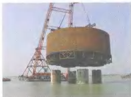
安装吊箱围堰
