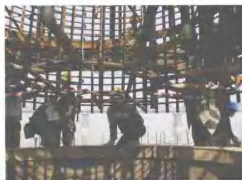
钢筋笼吊放及其桩底压浆管布置
