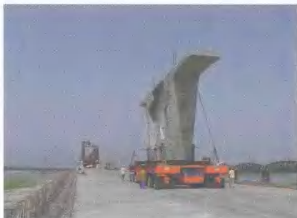
运送箱梁节段上桥
