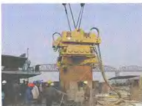
APE 振动锤插打钢护筒
