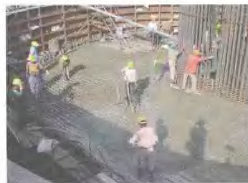
灌注承台混凝土
