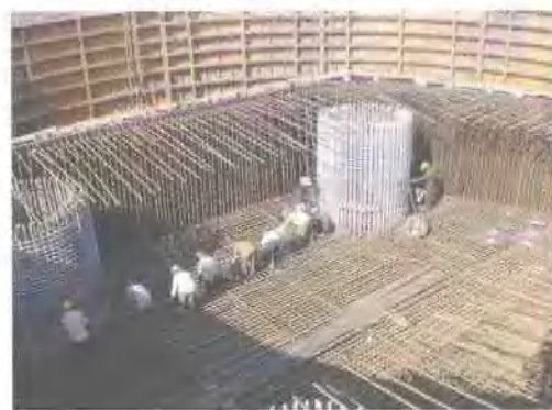
绑扎承台钢筋
