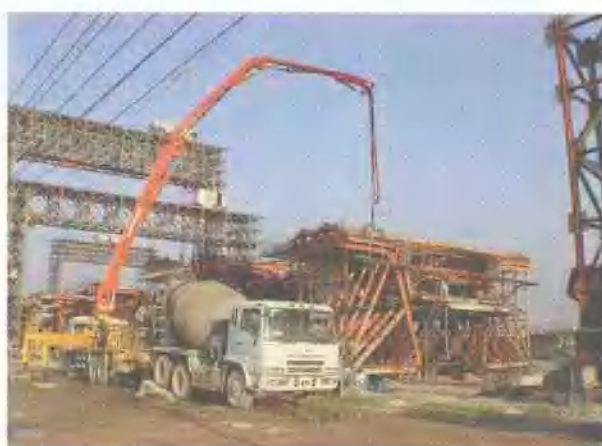
节段箱梁灌注混凝土
