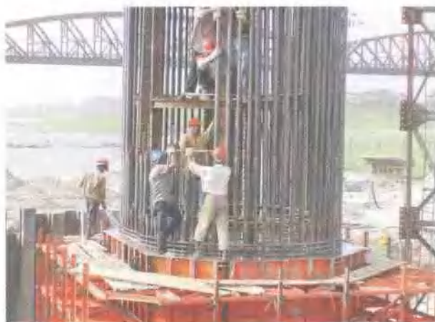
绑扎墩身钢筋
