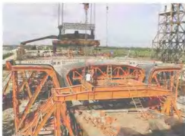
安装箱梁节段模板
