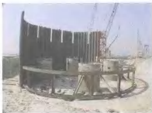
安装钢板桩围堰
