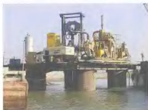
水上施工平台及钻孔施工
