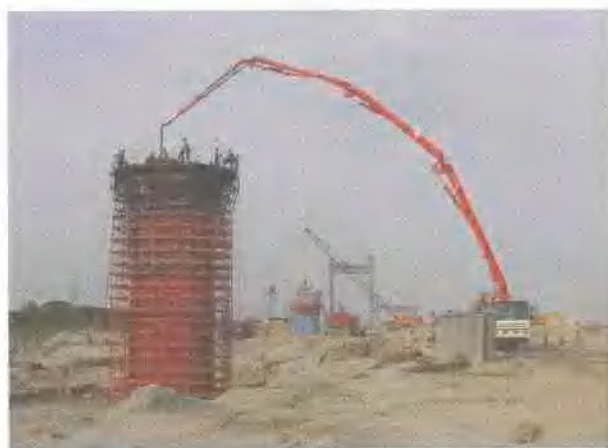
墩身采用无拉杆外模施工
