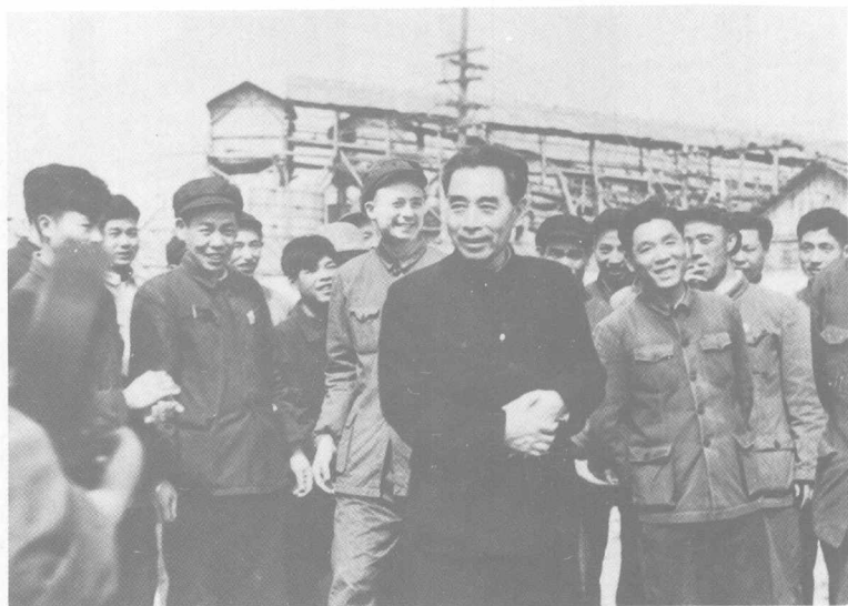
1959年4月9日，周恩来到新安江水电站建设工地视察，详细询问了电站施工的情况，热烈赞扬了电站建设者们自力更生建设电站的革命精神和冲天的革命干劲。
