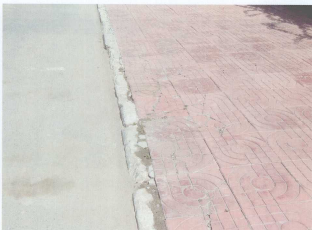
图 1.1-16 侧石、人行道板破碎
