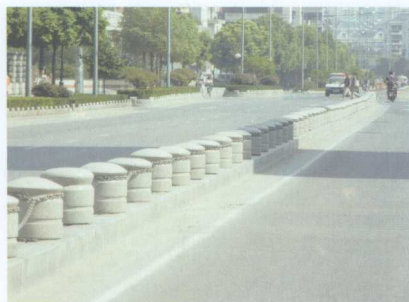
图 1.1-21 分隔带片面追求新颖忽视绿化
