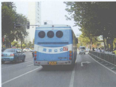
图 1.1-6 机动车道宽度不足
