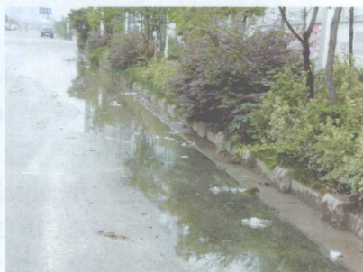
图 1.1-23 支路路缘石选材高档忽视排水基本功能
