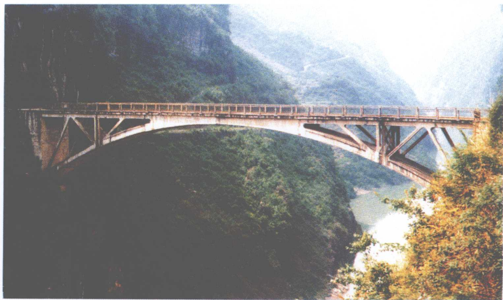
国内首座预应力钢筋混凝土桁架拱桥——道真自治县长岩大桥
