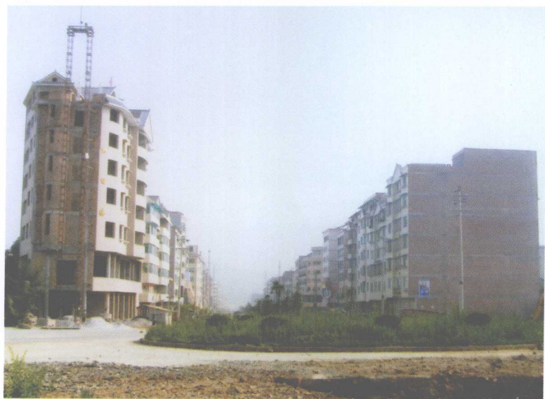
正在建设中的 县城尹珍大道
