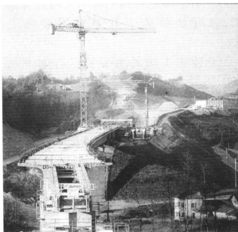
图 1-6 顶推施工法
