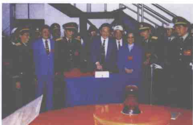
1995年9月3日，国务院副总理吴邦国视察水电部队承建的羊湖水电站，亲自按下由十支队安装的一号机组空载调试电钮。
