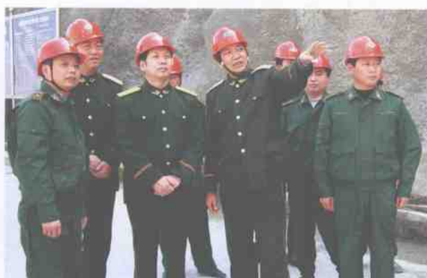
2004年3月1日，武警水电指挥部政治委员吴云峰到二总队三峡指挥所承建的三峡临时船闸改建冲沙闸工地检查指导工作。
