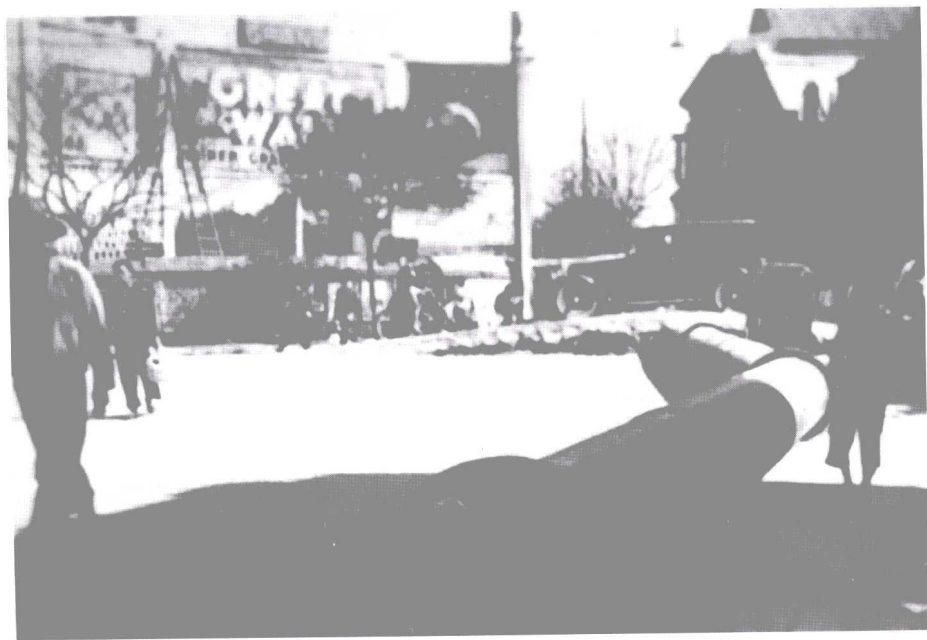
利用海河的疏浚土吹填市区洼地，图为20世纪30年代铺设在市区的排泥管线（今曲阜道一带）
