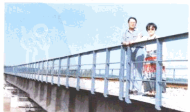
作者与《咸阳日报》副总编罗健在兰新复线建设工地
