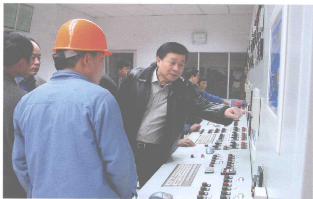
视察电力设施建设情况（2004年）
