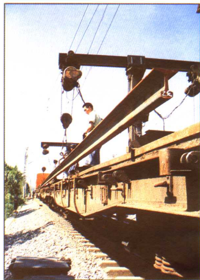
T型吊机卸轨作业
