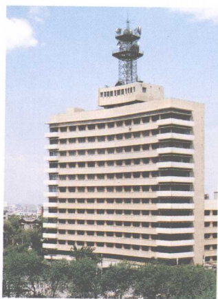
黑龙江省电力调度大楼（旧）
