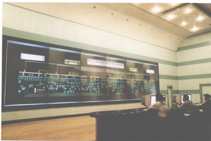
哈尔滨电业局调度大厅
