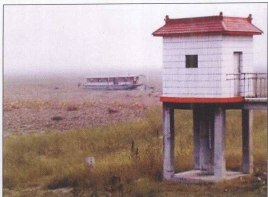
二级坝闸上的干湖、“旱”站、“旱”船
