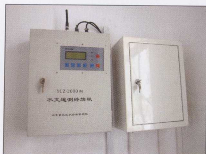
水位遥测终端机采集断面水位信息
