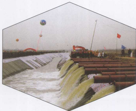
向上级湖补水微山西临时泵站开通翻水
