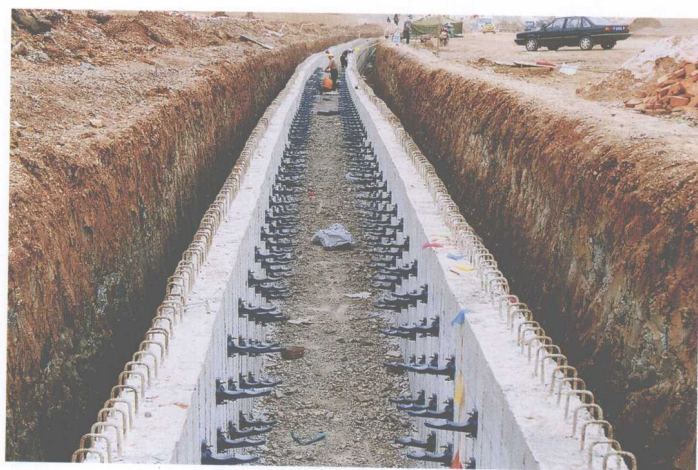
建设中的新潭2号路管沟
