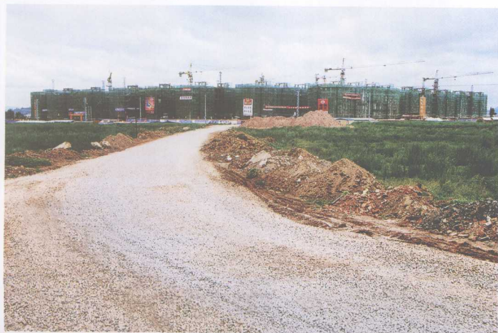
建设中的大渔乡部分社区搬迁安置房 (唐荣华 摄)
