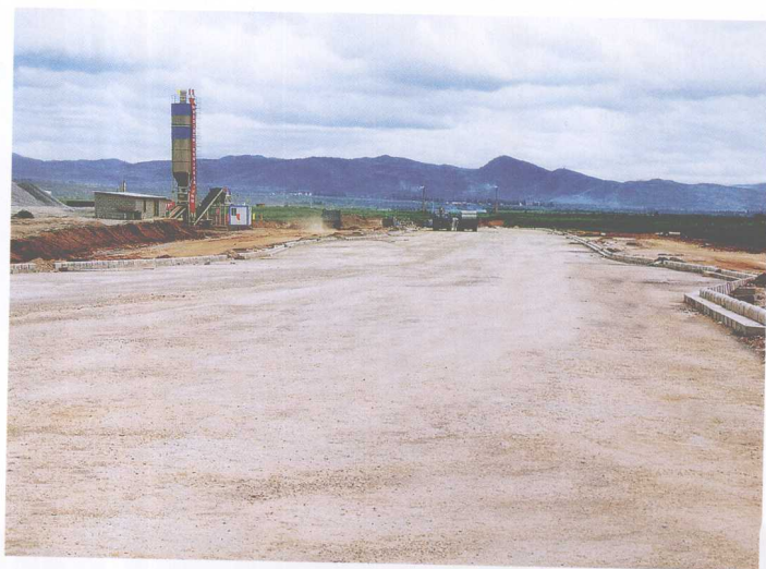
建设中的马金铺高新区东中环路
