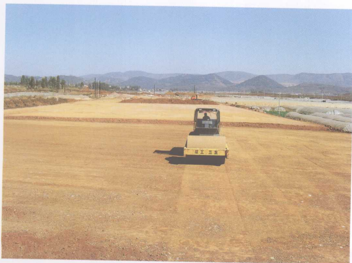
建设中的前新路
