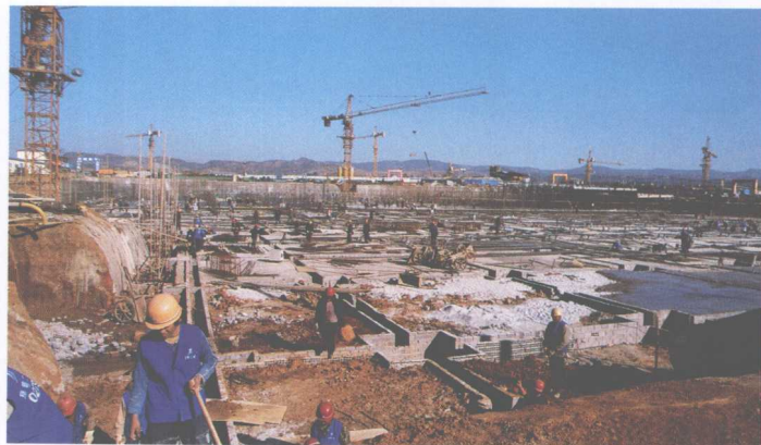
市级行政中心单个组团建筑地下室建设
