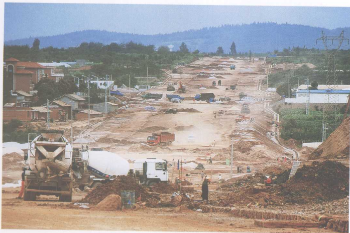
建设中的新潭2号路
