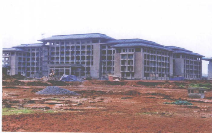
主体工程完工的市级行政中心单个组团建筑
