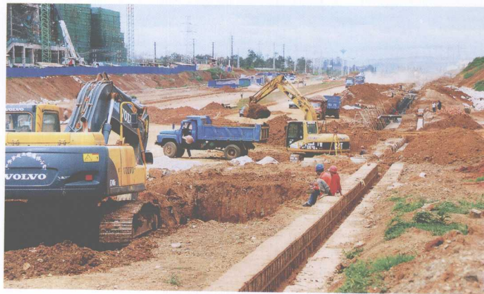
建设中的新潭1号路
