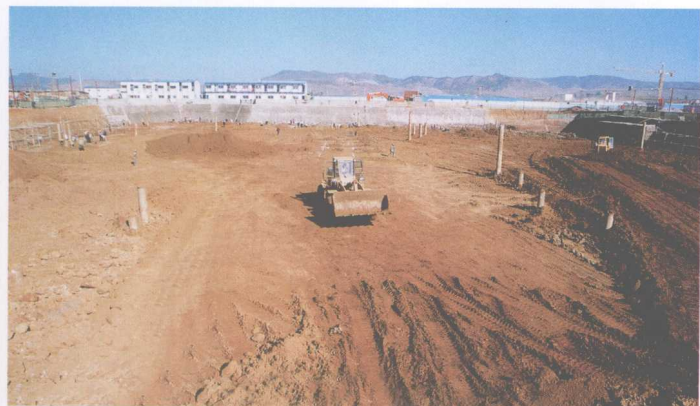
市级行政中心单个组团建筑地下室开挖
