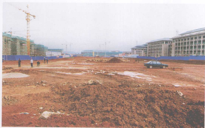
建设中的市级行政中心
