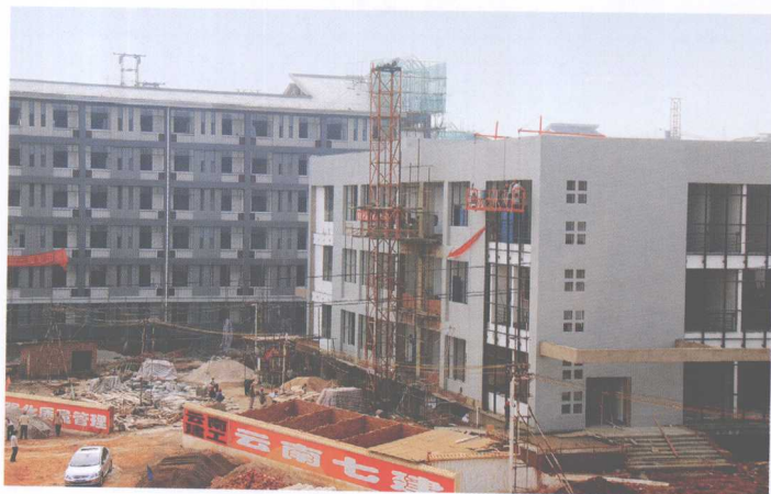
云南师范大学部分即将竣工投入使用的单体建筑
