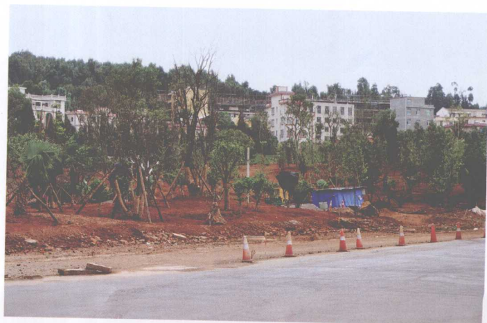
建设中的昆玉高速公路进入呈贡县城绿化景观工程
