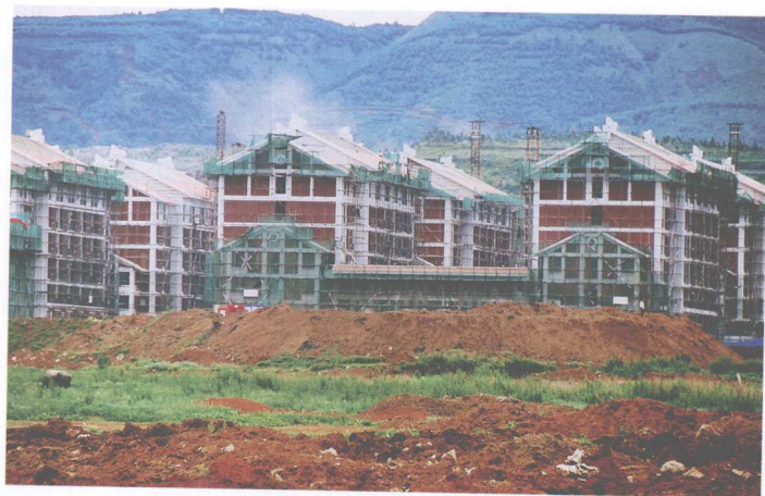
云南民族大学即将竣工投入使用的单体建筑
