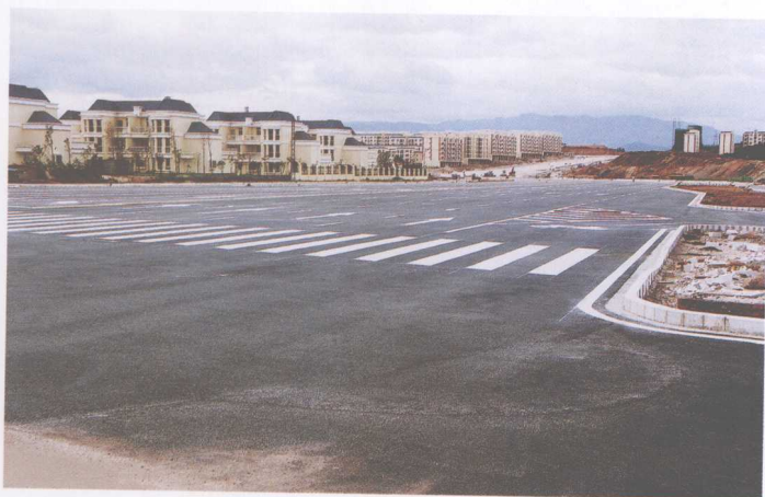
即将竣工的呈贡新区新呈贡道路建设工程
