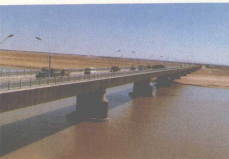
黄河公路大桥
