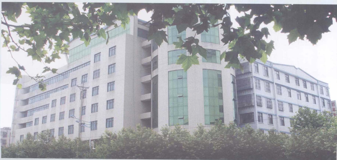
2001年10月建成的教育局机关办公楼
