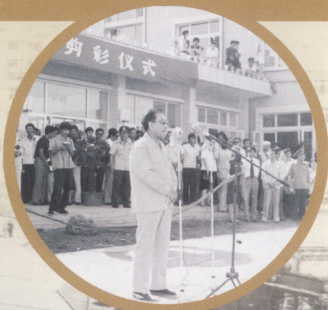
正在建设的青年宫现场和青年宫开工剪彩仪式。
