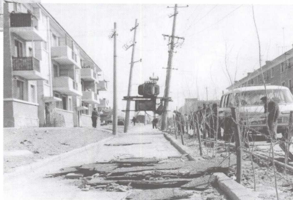
1984年4月24日，克拉玛依大风。 铁条围墙和砖砌桩子被风吹倒。
