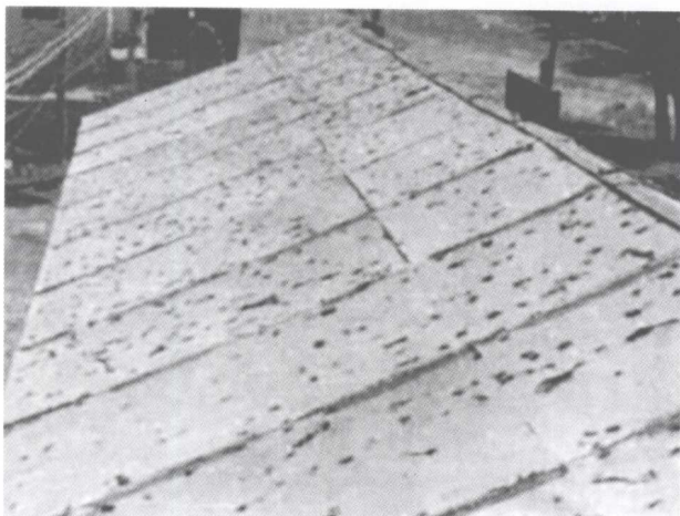
1982年8月1日，克拉玛依乌尔禾地区特大冰雹。图为活动房纸精板被冰雹砸穿的坑印。
