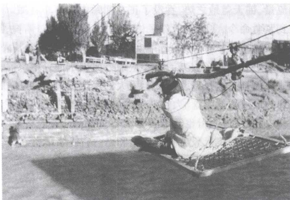
1958年8月12~13日，库车洪水，当地群众制作出简易的钢丝悬索桥，在救灾中起到联结两岸交通的重要作用。
