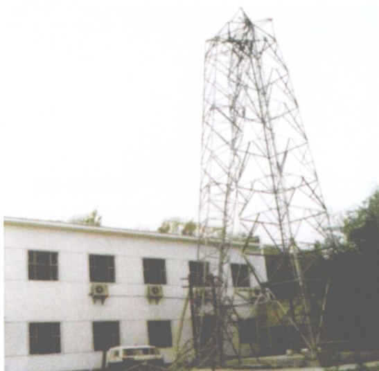
1998年4月18日，克拉玛依大风，乌尔禾地区邮电通讯塔被大风拦腰刮断。
