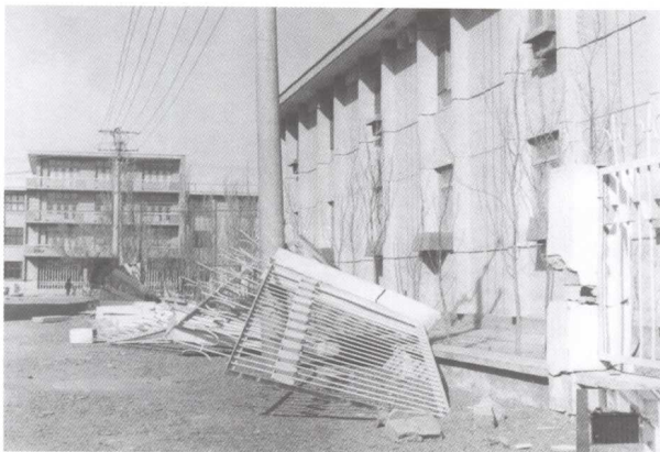
1984年4月24日，克拉玛依大风。 铁条围墙和砖砌桩子被风吹倒。
