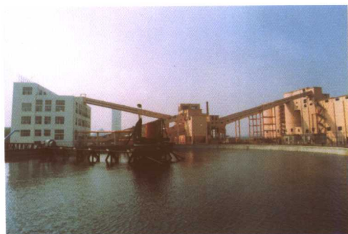
现代化的济宁二号煤矿洗煤厂
