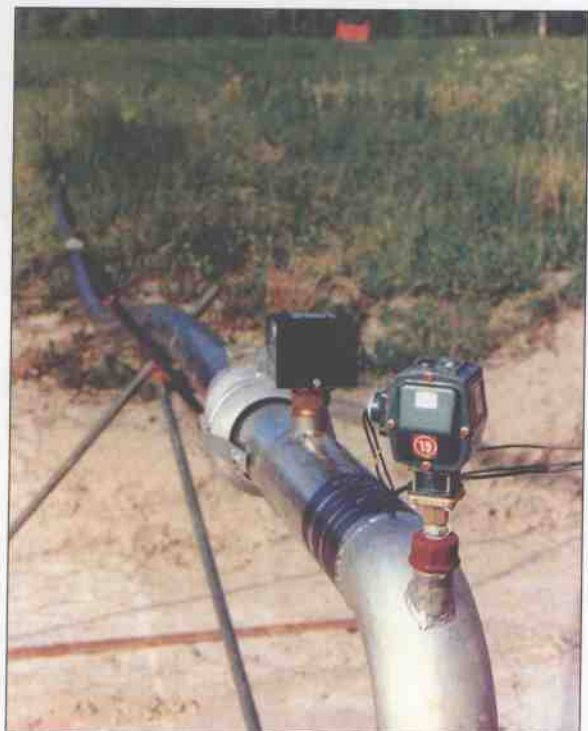
图 3. 保护装置在包括灌溉在内的许多领域都有应用。在这种应用中，堵塞可能使压力上升到危险的程度
